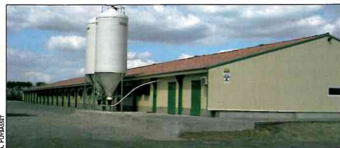
La toiture en tôle flammée a été choisie par l'éleveur pour une meilleure intégration paysagère.
